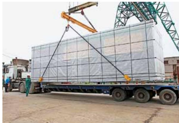
Транспортировка модуля котельной автотранспортом
